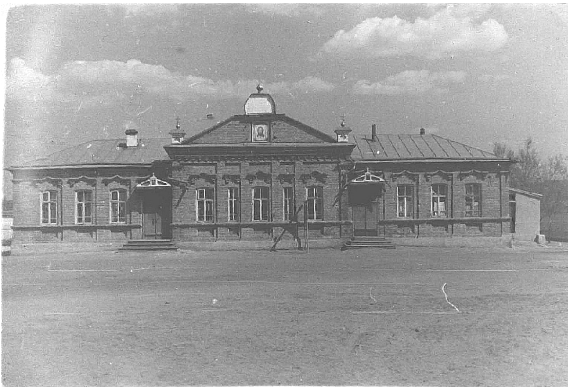
Владимирская школа-церковь г. Актюбинска.
